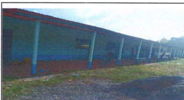
Foto 4: asi se finizo la pintada del establecimiento
