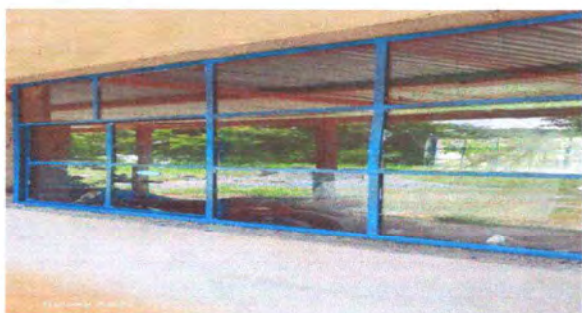
Foto 1: Cambio de ventanas de mallas por vidrio.
